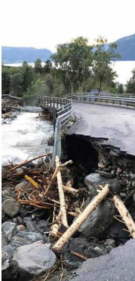
Flaumskader på fv. 60 ned mot Utvik sentrum i juli 2017. Foto Statens vegvesen.
